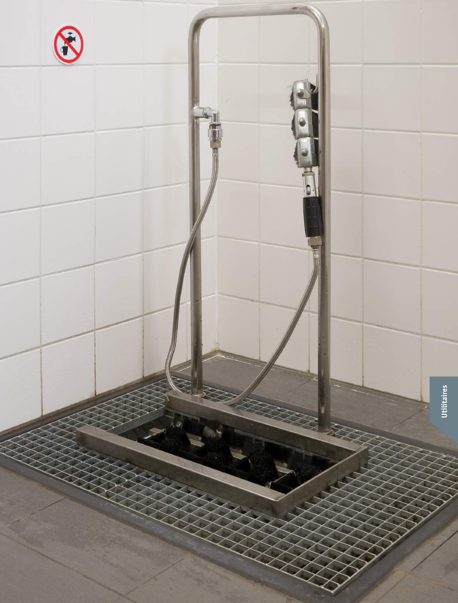
Installation de lave-bottes - Caserne de pompiers de Kasterlee
