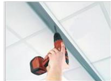
Bevestiging van de kantoorwand onder het plafond
