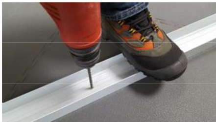
Bevestiging van de kantoorwand op de grond
