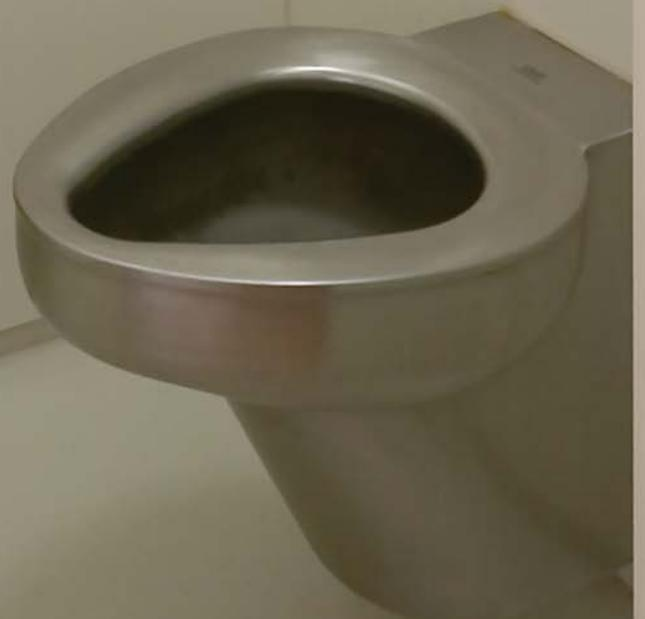
Toilettes Robusto I avec chasse d'eau pneumatique Geberit, lavabo anti-vandalisme et miroir de sécurité moulé Robusto - Police, Schiphol
