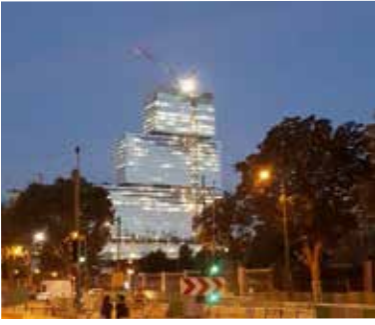
Palais de Justice de Paris Architecte : Renzo Piano Cabines : SVF30 ALTUS Portes: stratifié compact Sanitaire inox Accessoires inox
