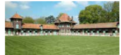
Haras de Jardy Architecte : IPSO FACTO Cabines : VITRUM II
